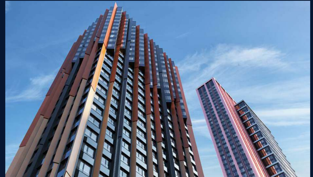
↑ фасады корпусов очередей 1-2
