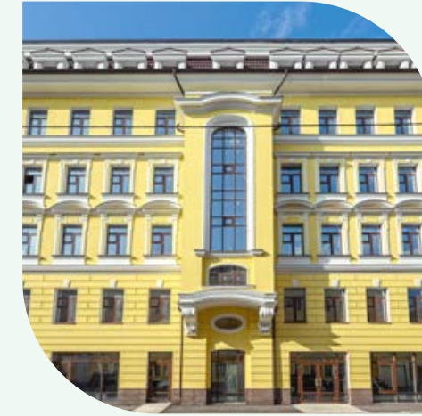
Новый Балчуг Бизнес-центр Москва
