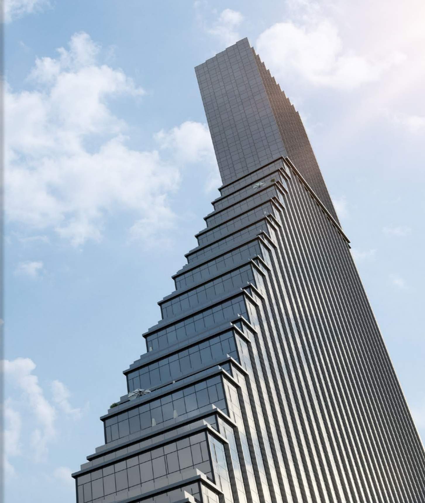
вид на фасады
